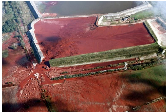
4. ábra Ajkai vörösiszap katasztrófa: átszakadt zagyatározó
